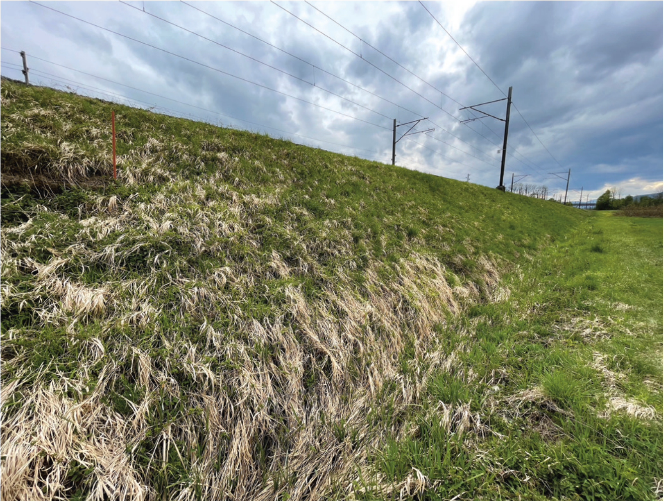
Verbrachte Bahnböschungen, leider ein häufiges Bild entlang von Bahngleisen.
