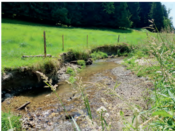
Einer der Bachabschnitte am Rotbach, welcher der Biber bereits nach seinem Gusto gestaltet hat. Hier können wir auf weitere Aufwertungsmassnahmen wie einen Uferanriss verzichten.
